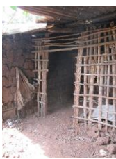
Eine Konstruktion aus Holzstecken und Lehm
